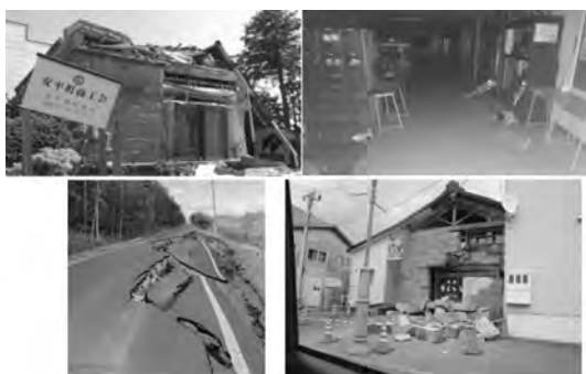
写真1 北海道胆振東部地震による被災状況 安平町震度6.5強
