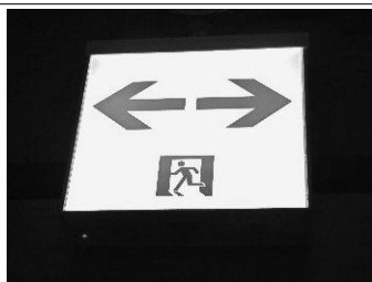
写真2 通路誘導灯(LEDタイプ) 1)
