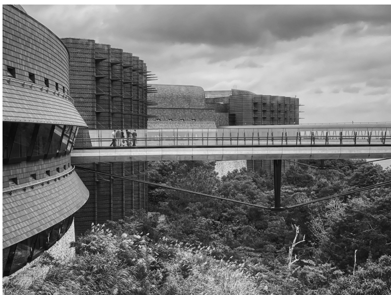
写真2 各研究棟間をつなぐブリッジ
