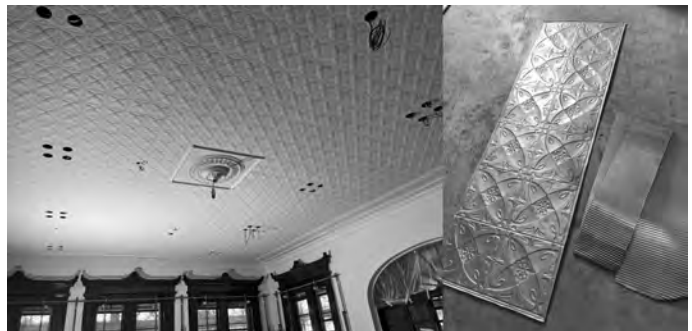
写真4 メタルシーリングを使用した天井
