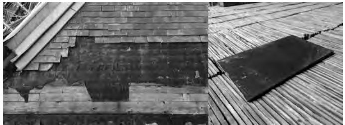
写真3 葺替え中の屋根と天然スレート
