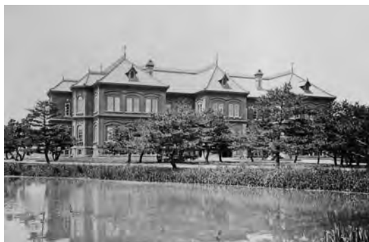
写真2 復旧工事後の八角塔のない赤れんが庁舎
