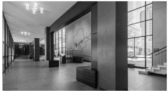
写真8 門型フレームで補強した玄関棟内観
