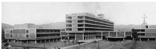
写真1 1956年創建時の県庁舎
