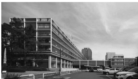
写真4 本館(玄関棟含む)・南館・議事堂
