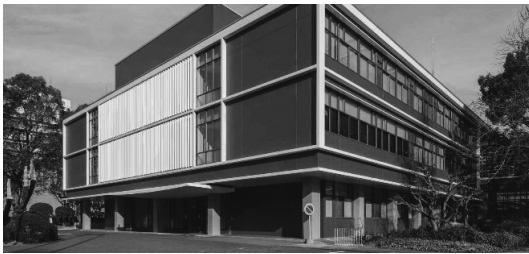
写真7 耐震補強後の議事堂
