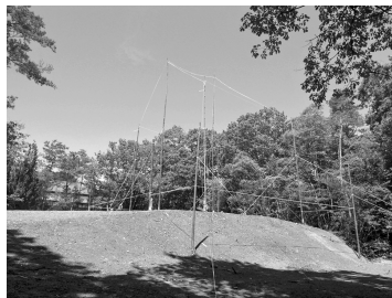
写真3 芝川又右衛門邸移築の際の竹竿を用いた配置の検討(左/2005年)と移築竣工後(右/2007年)
