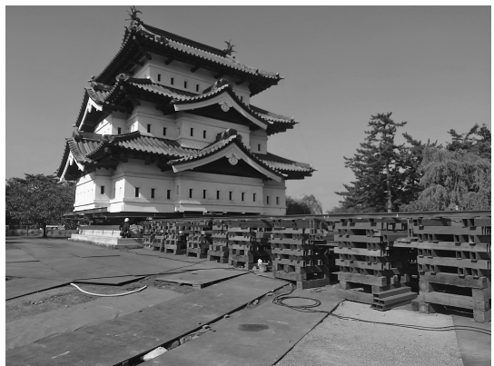
写真 弘前城の曳家工事
