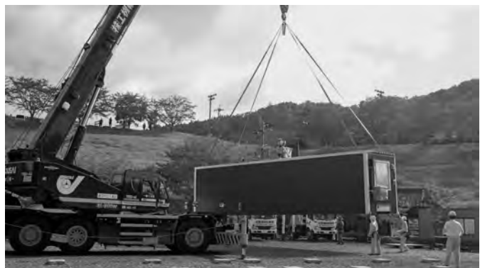
写真3 ムービングハウス設置工事
