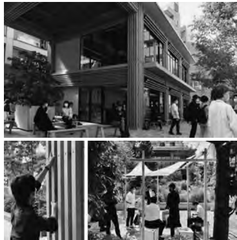
写真4 外装材を什器等に再利用できる仕組み
