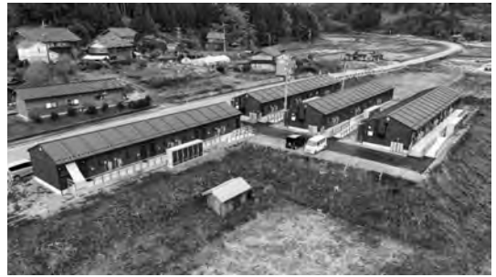
写真1 現地で本設移行する応急仮設住宅の例
