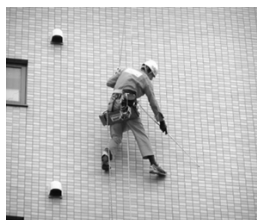
写真3 ローブランコによる調査状況
