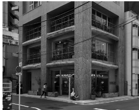
写真7 3層ごとのメガストラクチャー混構造 (平和不動産 KITOKI) 筆者撮影
