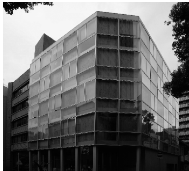
写真6 鉄骨造にCLT耐力の混構造建築 (兵庫県林業会館) 筆者撮影
