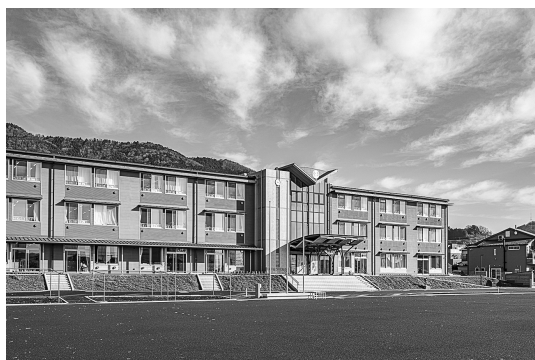
写真5 木造3階建て校舎(松田町立松田小学校)
