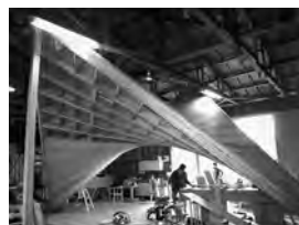
写真3 HPシェル原寸 棟梁が製作
