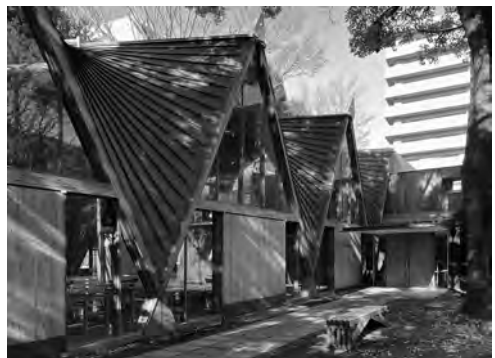
(図・写真1～7：河野泰治・伊藤千遥、河野泰治アトリエ)
