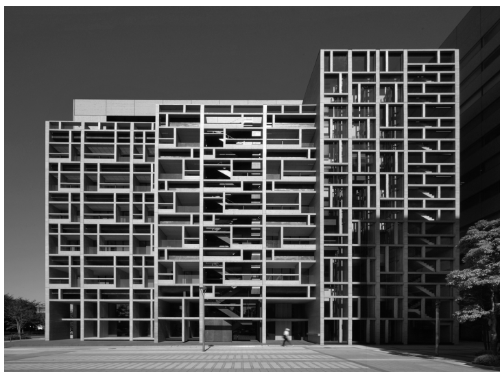
写真1 新築時の木材会館の全景
