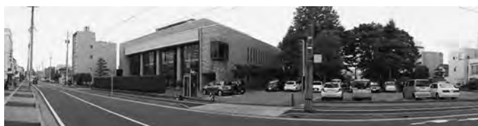
写真1 リニューアル前の福井市立図書館全景
