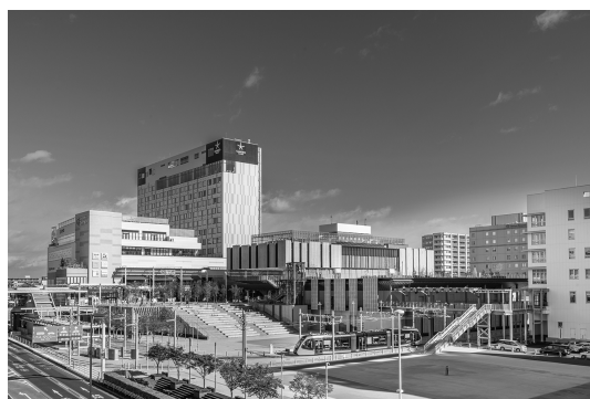
写真2 駅東口の様子
