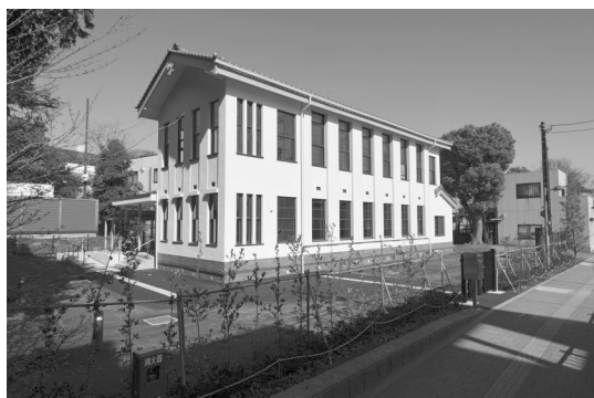
写真4 南側(今小路通り側)の外観
