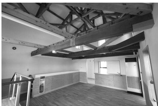
写真6 旧書庫部分の小屋組と吹抜(3階床撤去)
