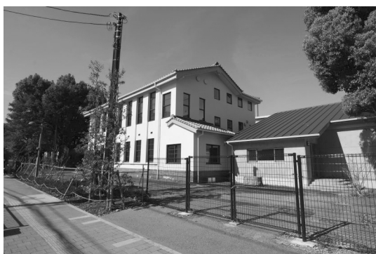
写真8 既存部の東側に RC 造増築部（写真右）
