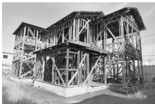
写真2 旧鎌倉図書館の工事中断中の状況
