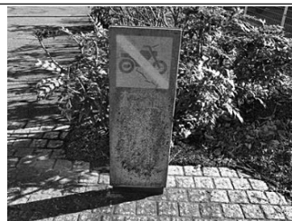
写真2 案内表示の劣化による視認不良 1)
