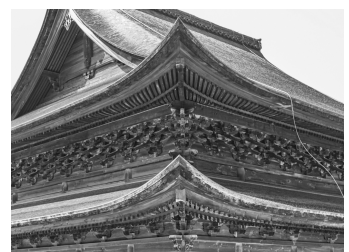
軒下の部材の複雑かつ整然とした納まりが特徴的である 図8 不動院金堂の軒下の構造
