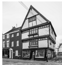
大きく傾いた建物の中に鉄骨補強を挿入している
