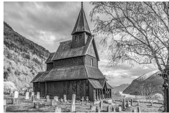
12世紀に建てられた軸組構法の教会建築 図5 ノルウェー・ウルネスのスターヴ教会
