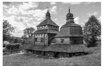
屋根のドームも含めて、ログハウス構法で造られた16世紀初頭の教会建築
