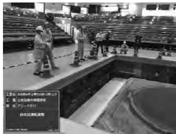
土俵せり上げ装置改修
