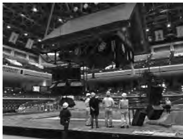
吊り物設備(屋形・バトンほか)改修
