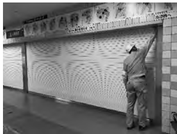
売店防煙シャッター改修
