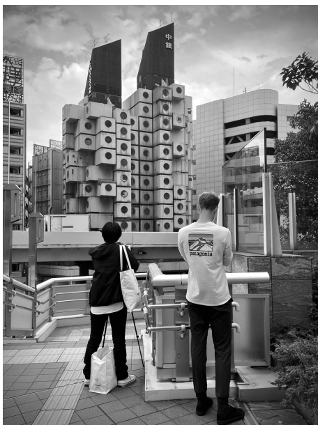
写真 解体直前の中銀カプセルタワービル
