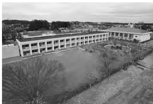
写真1 南側からの全景
