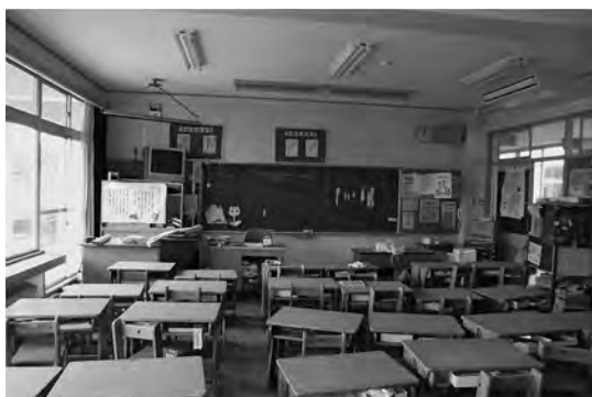
写真2 改修に着手前の普通教室
