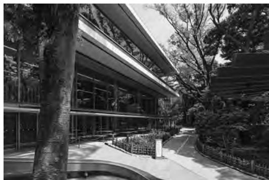
写真3 開口部の深い庇
