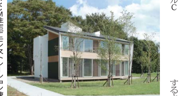
LCCM住宅モデム(ストレージョン棟)
