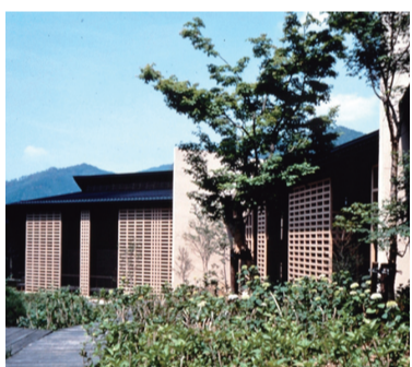
長野県の「稲荷山養護学校」は、構造と床以外の仕上げすべてに、長野産のカラマツ材を使っています。カラマツのムク材は変形が激しく使用を敬遠しがちな材料ですが、県の30年以上にわたる研究により、構造材として十分オリエーティの高品質材料と分かりました。ここでは、構造材を金物を使わずに「めり込み」作用を利用して接合しています。また、一般に流通する105角の小径材を使って大型木造建築をつくることに挑戦しました。山の保全を考へて間伐材を使い、県の努力でトレーサビリティを実現。つまりすべてこの材料の出どころを記録し、子どもたちに伝えて教育にも役立てています。
