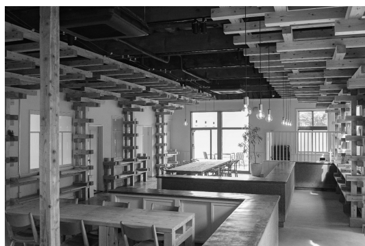
写真3 補強を兼ね備えた伝統技術による装飾
