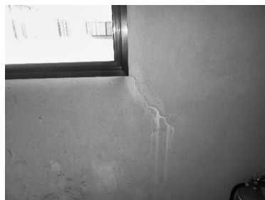
写真2 壁の漏水痕
