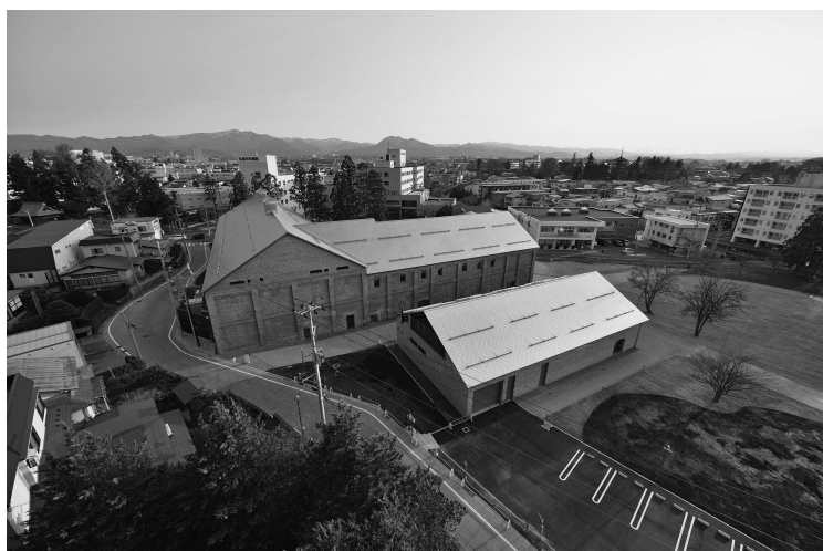
写真3 シードル・ゴールドの屋根 ©Naoya Hatakeyama
