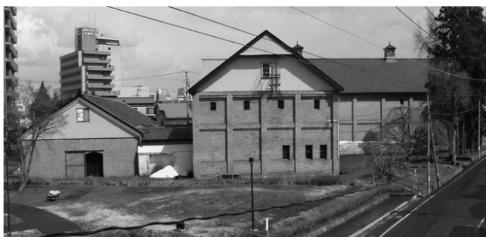
写真2 整備前の煉瓦倉庫
