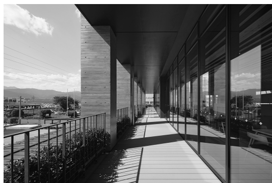
写真3 2階アウトフレーム
