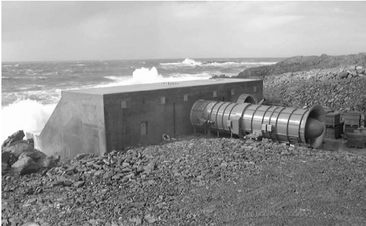
写真3 海岸設置振動水柱型波力発電装置「LIMPET」 4)
