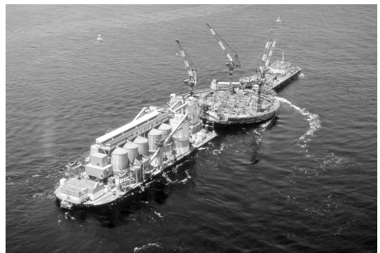
写真2 コンクリート打設状況
