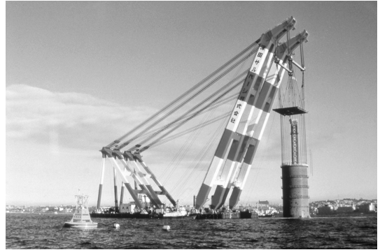
写真1 模擬ケーソン
