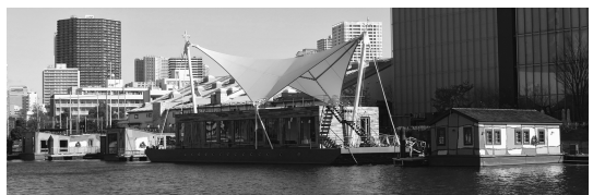
写真7 天王洲の水上建築群(2020年2月撮影)
