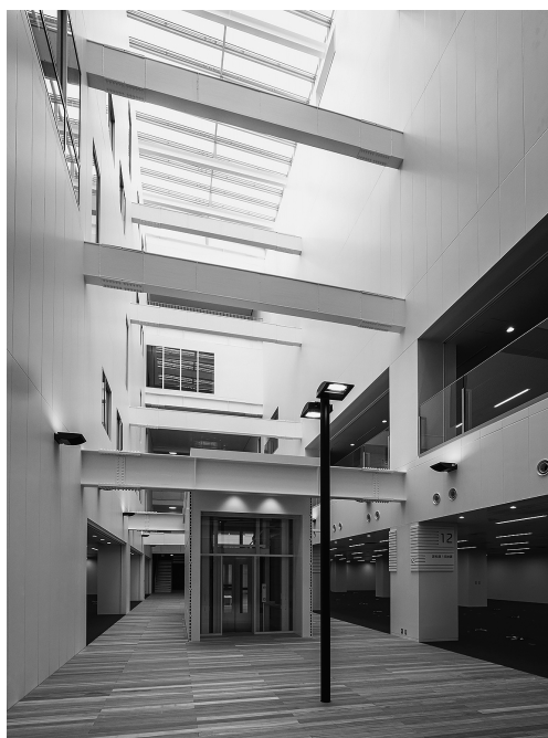
写真3 減築による吹き抜け
