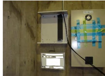
図 1.7.2 操作部の養生例
