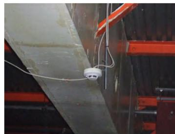
図 2.1.15 仮設感知器の施工例
