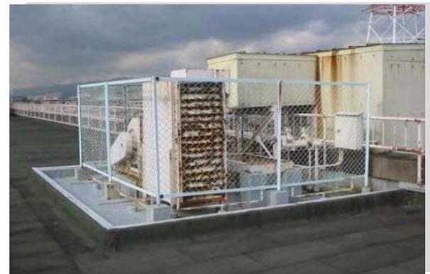
室外機ではガス空調はガスエンジン、電気空調は電気モーターの働きで冷媒を圧縮しています。
